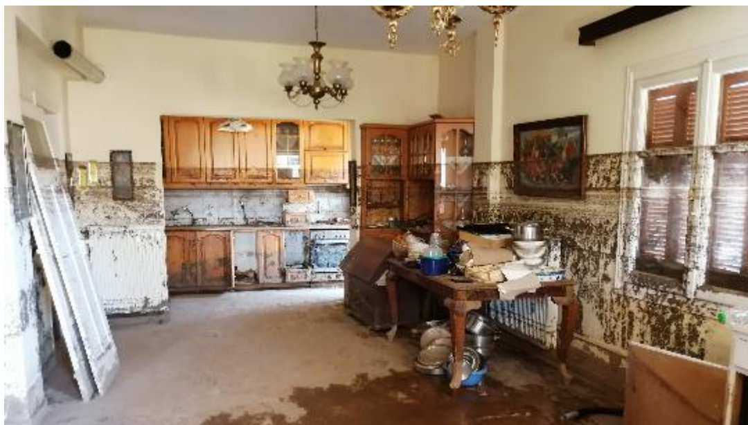
Αποτύπωμα της πλημμύρας στο εσωτερικό του σπιτιού. Εύβοια, Αύγουστος 2020. Φωτογράφιση: Ν. Ευελπίδου
